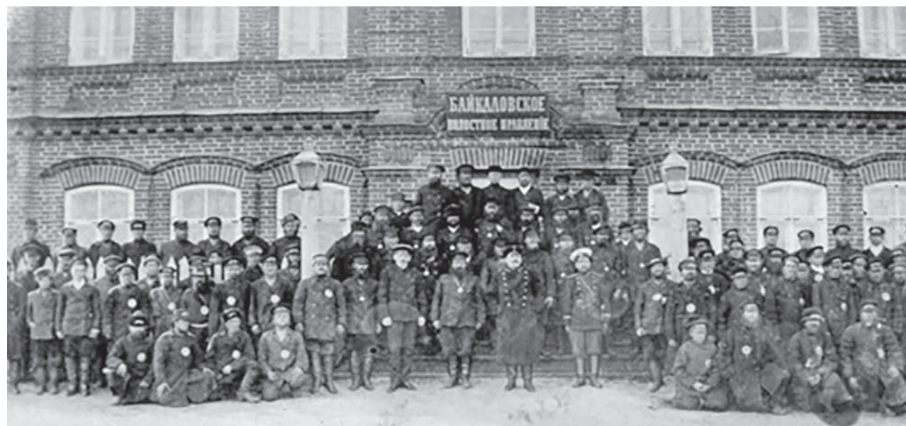
В 1898-1901 годах строится кирпичное здание школы (современная школа-интернат).
